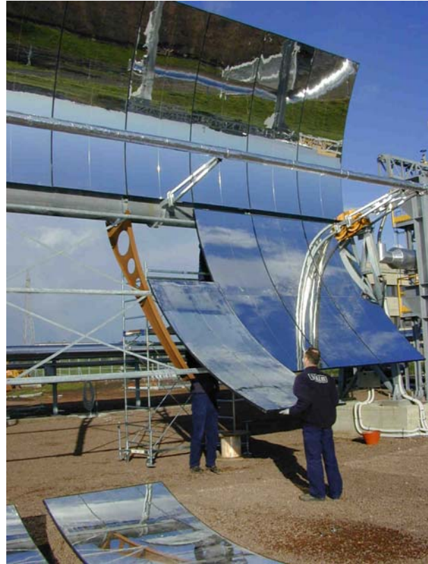
Fig. 16 - Montaggio degli specchi di prima generazione (Powerwall)
